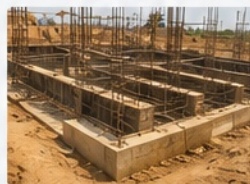
Fondations d'un bâtiment
