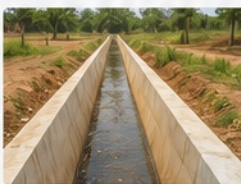
Caniveau bétonné
