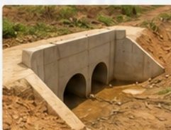
Ouvrage de dalot
